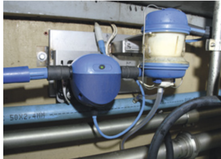
Het minilaboratorium wordt tegelijk met de melkinstallatie gereinigd. Om te voorkomen dat kalk zich op het glas van de laser en de sensor afzet, blijft er altijd water in het apparaat staan. Dat water moet je kort voor het melken laten weglopen.
