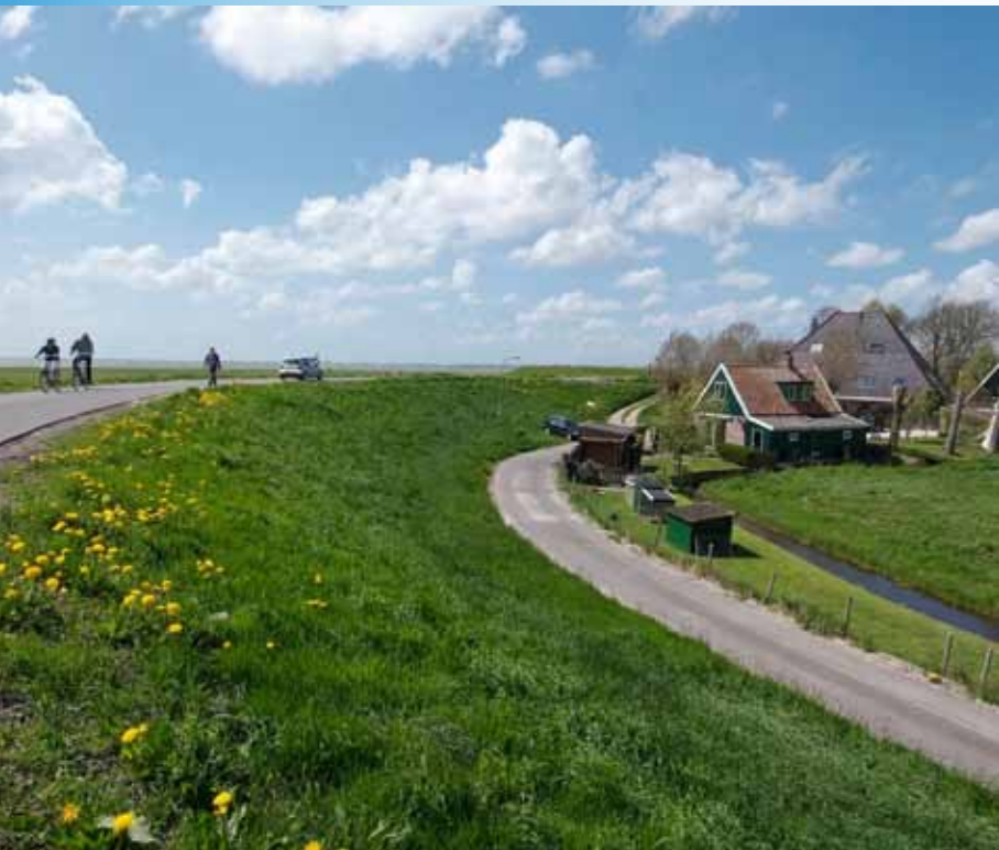
Dijkversterking Zuiderdijk, gelegen tussen Enkhuizen en Hoorn. Een project in het kader van het Tweede Hoogwaterbeschermingsprogramma (HWBP-2), uitgevoerd door Hoogheemraadschap Hollands Noorderkwartier.
