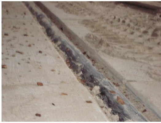
Foto 1 Voorbeeld van de positie van de beluchtingsbuizen tussen de betonplaten.
