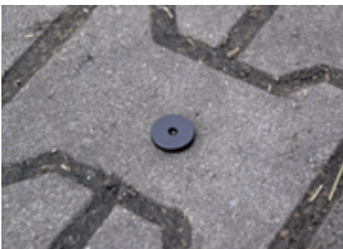
In de verharding worden transponders ingebracht. Die moeten ervoor zorgen dat de robot zijn weg over het erf vindt.
