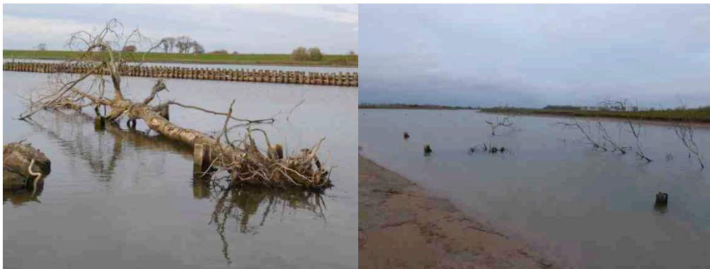
Figuur 4.5: De bomen bij Everdingen zijn verankerd aan stalen H-balken: vier per boom in de kribvakken (links) en twee per boom in de strang (rechts). (Foto's tijdens laagwater 7 november 2015).
