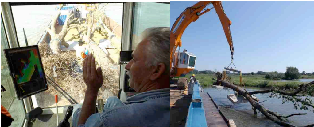
Figuur 13,14: Het afzinken van de bomen is precisiewerk: het is dan ook belangrijk dat de kraanmachinist ter plekke de diepte en de actuele plaats van het schip en de bomen in beeld heeft.
