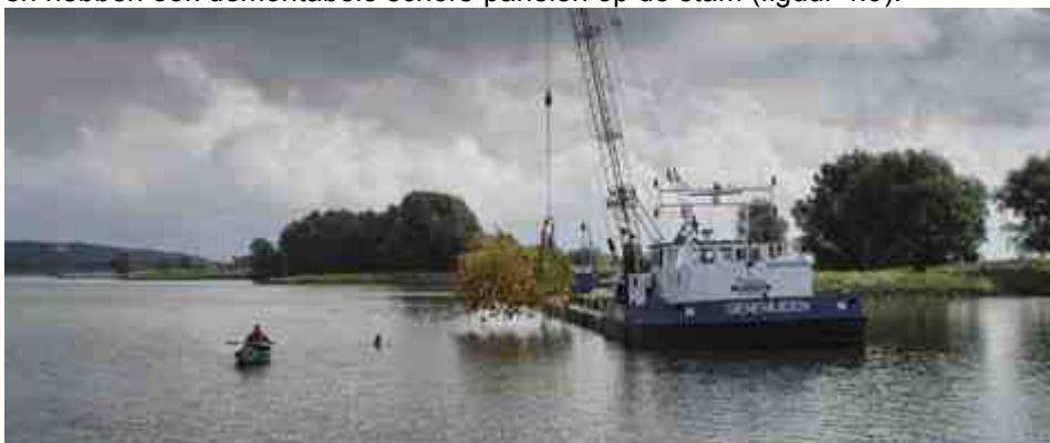
Figuur 4.9. Kastanjeboom wordt met betonplaten afgezonken in de Nederrijn bij Wageningen. De man in de kano maakt filmopnamen voor de documentaire 'Levende rivier' (foto: RWS)
