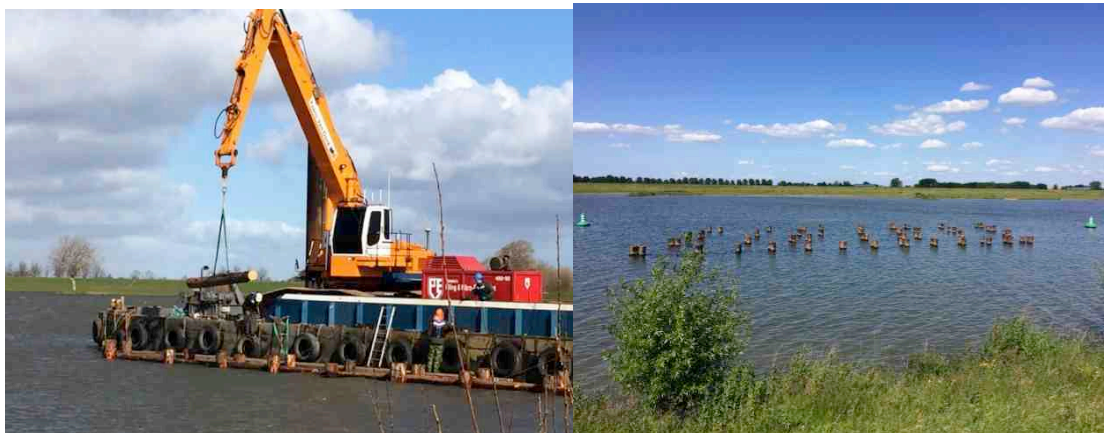
Figuur 15: Aanleg bomenscherm met kraanschip bij Culemborg
