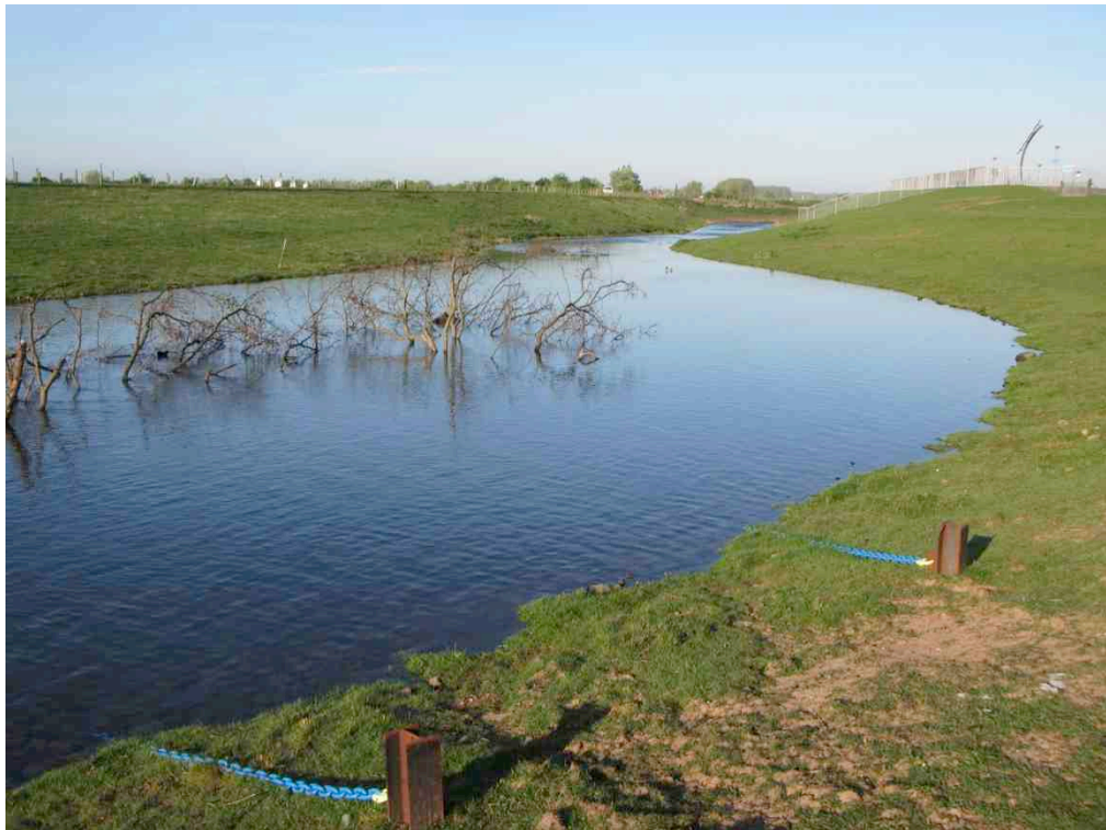
Figuur 4.4b: De bomen in de vistrap bij Maurik zijn met kettingen verankerd aan vier stalen H-balken op de beide oevers.
