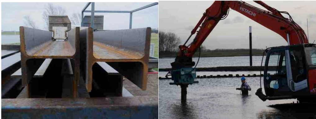
Figuur 4.3: Intrillen van stalen balk in kribvak bij Everdingen
