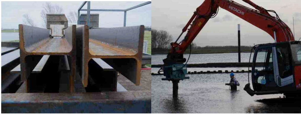
Foto 7,8: Intrillen van stalen balk in kribvak bij Everdingen
