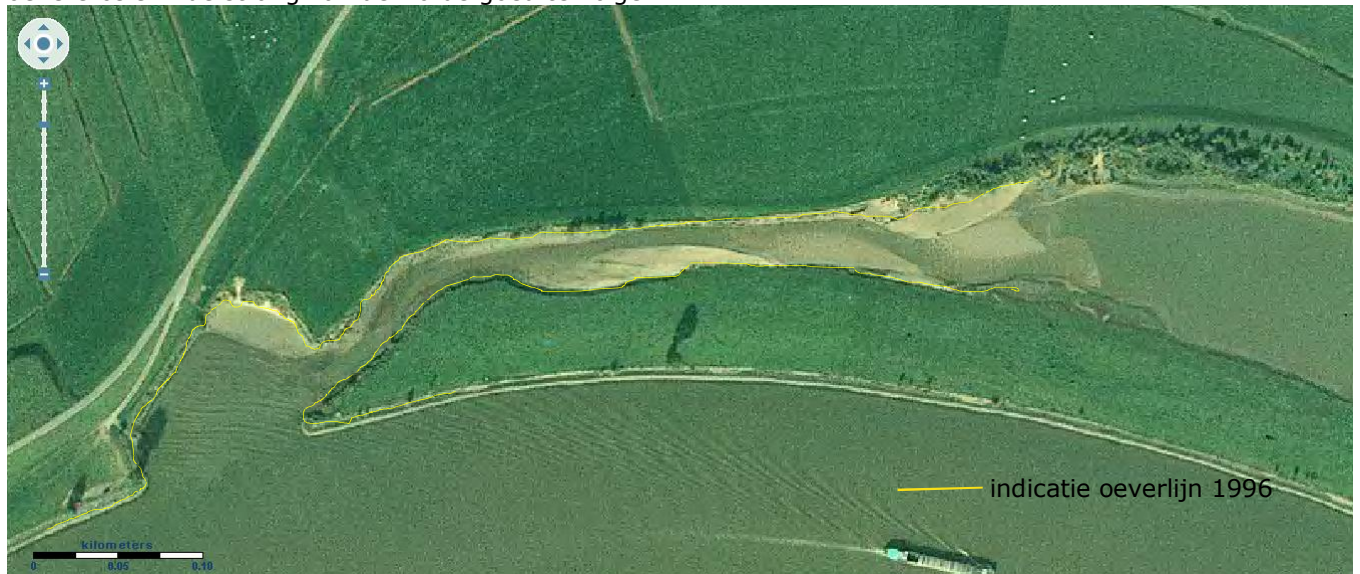
Figuur 6-a Opname de Horde, 1996.
