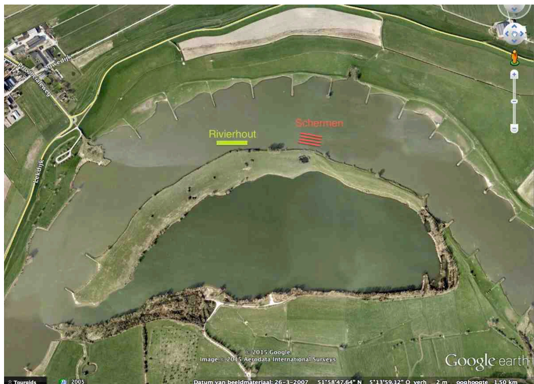
Figuur 3.7. Locaties schermen en rivierhout bij de Redichemse waard. Het rivierhout (losse boom) is als referentie voor de ecologische monitoring aangebracht zodat de effectiviteit van de schermen vergeleken kan worden met die van een complete boom.
