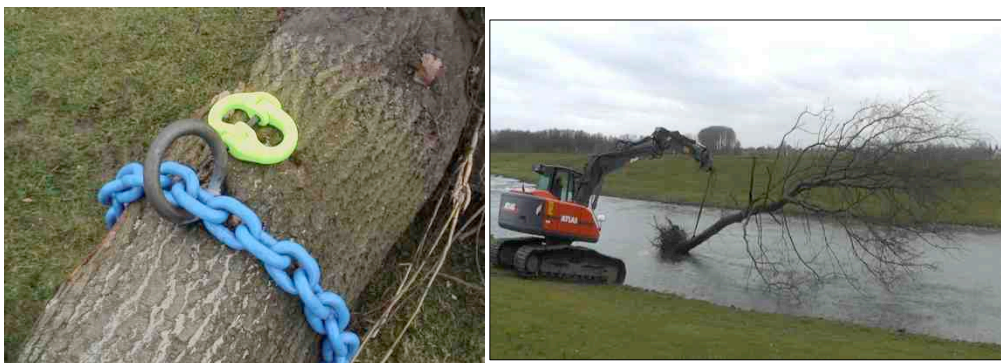
Figuur Foto 9,10: Stalen ketting door oog in de boom (links) en plaatsen boom in de vistrap bij Amerongen.
