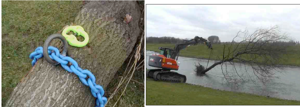
Figuur 4.4a: Stalen ketting door oog in de boom met losse verbindingsschalm (links) en plaatsen boom in de vistrap (rechterfoto: A. Klink).
