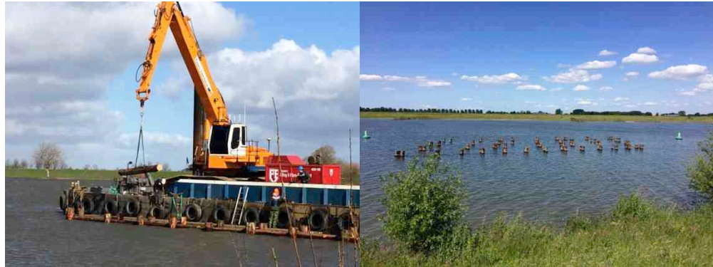
Figuur 4.10. Aanbrengen van bomen voor het eerste scherm (links) en het eindresultaat (rechts).
