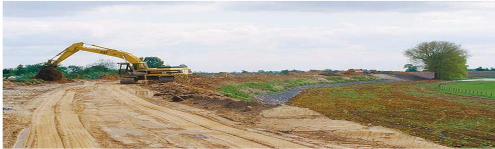
Figure 31: Elargissement et rehaussement d'une digue
