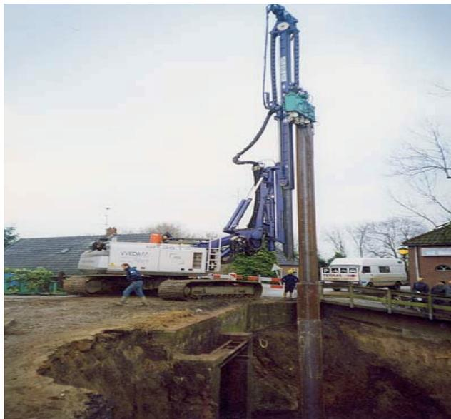
Figure 32: Réfection d'une écluse, mis en place des palles-planches
