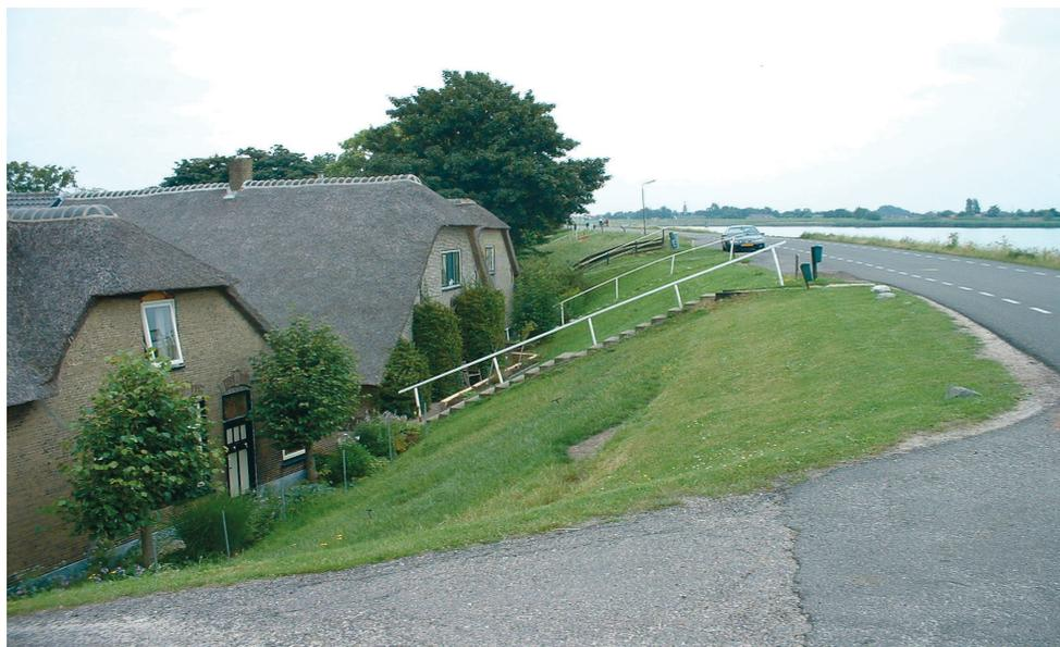
Figure 34: Des maisons bordées de remblais après plusieurs programmes de rehaussement des digues
