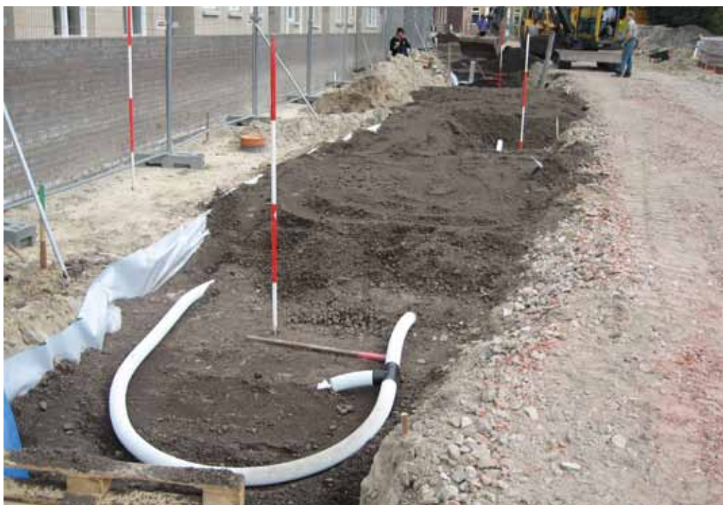
Boomstraat met granulaat in een wortelstraat.
