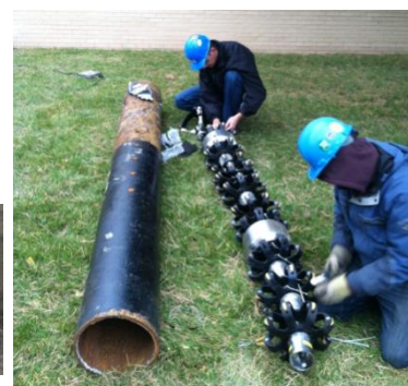
Afbeelding3. In-line inspectie met de See Snake van het bedrijf PICA
