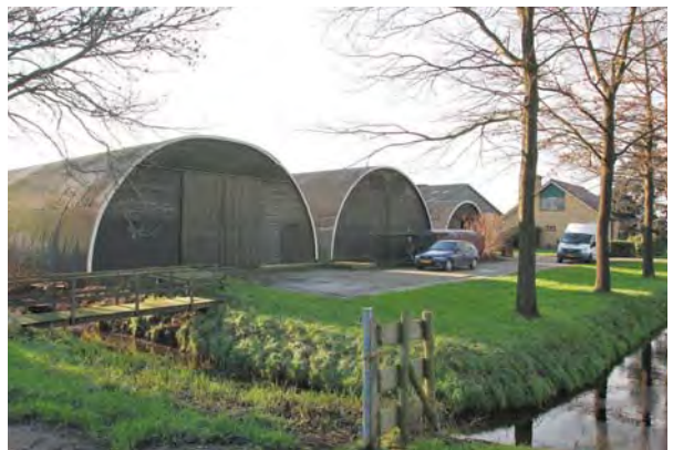
Op het erf vallen de drie romneyloodsen op. Bij de start van het bedrijf in 1972 werden die ingezet als proefstallen voor het toenmalige Imag.
