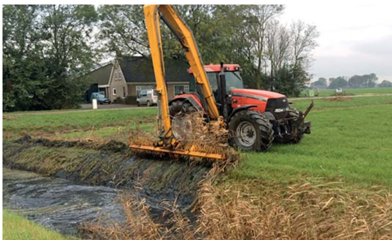
Slotenwerk is een belangrijke neventak, die goed past in de arbeidsfilm. Grondverzet wordt vooral uitgevoerd bij agrarische klanten.
