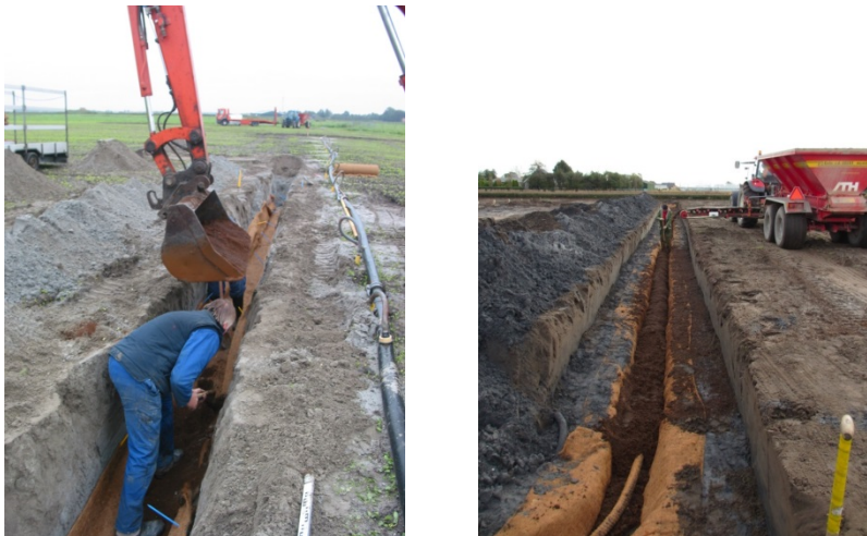
Figuur 6.1 Aanleg van een met ijzerzand omhulde drain. Links: in Egmond werd een smalle sleuf gegraven vanaf maaiveld; rechts: in Voorhout werd eerst een brede sleuf gegraven, van waaruit een smallere sleuf werd gegraven.
