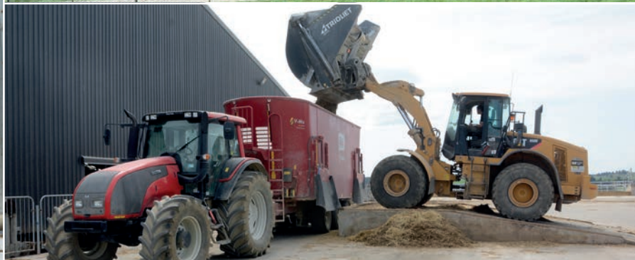
Foto boven: naast de nieuwe stal is voor 1.250.000 kuub aan mestopslag gerealiseerd
