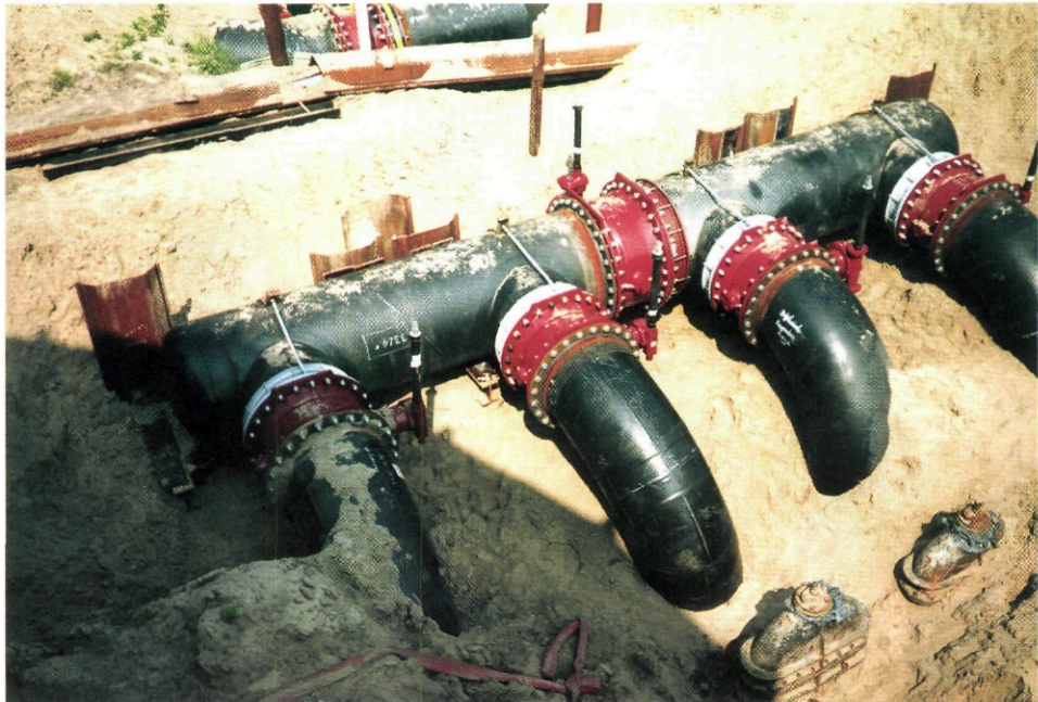
Afb. 13 - Aanleg van leidingen in terrein.
