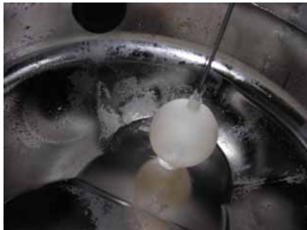
Foto 4 Voorbeeld van (kalk)aanslag in de luchtafscheider. Reinigen met zuur is noodzakelijk.
