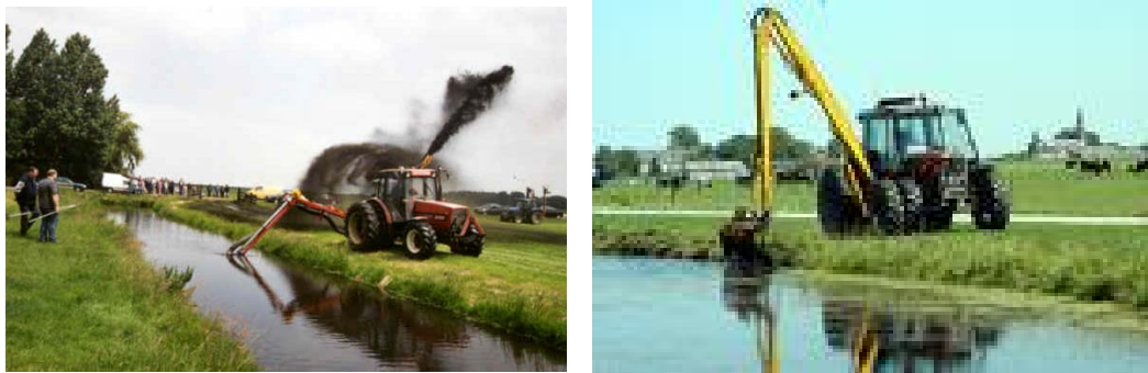
Figuur 1. Bagger verwijdering met een baggerspuit (links) of met een baggerschip (rechts). Afbeeldingen afkomstig van www.waterbodem.nl en www.zuidholland.nl .
