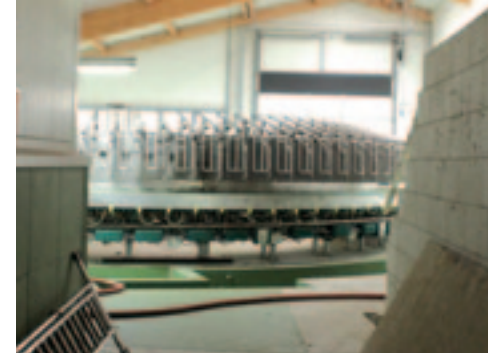
In aanbouw zijnde 100-stands buitenmelker met opmerkelijke noviteiten.
