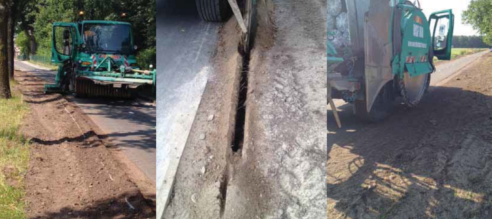
Machinale inbouw van het hoogwaardige RootBarrier® 360-wortelweringsscherm met de wortelweringsfrees WSF800
