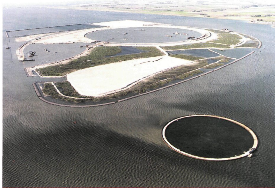
Aanleg van het baggerdepot IJsselooig in het Ketelmeer
