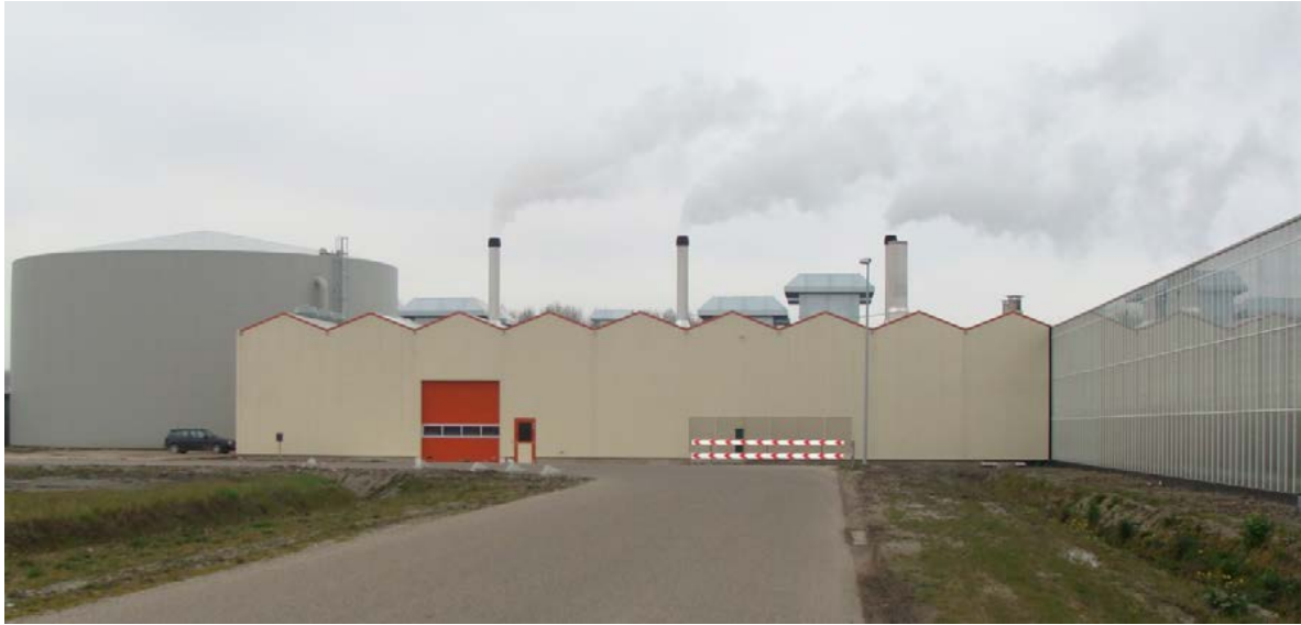
Ketelhuis met wk-installatie, ketel en warmtebuffer
