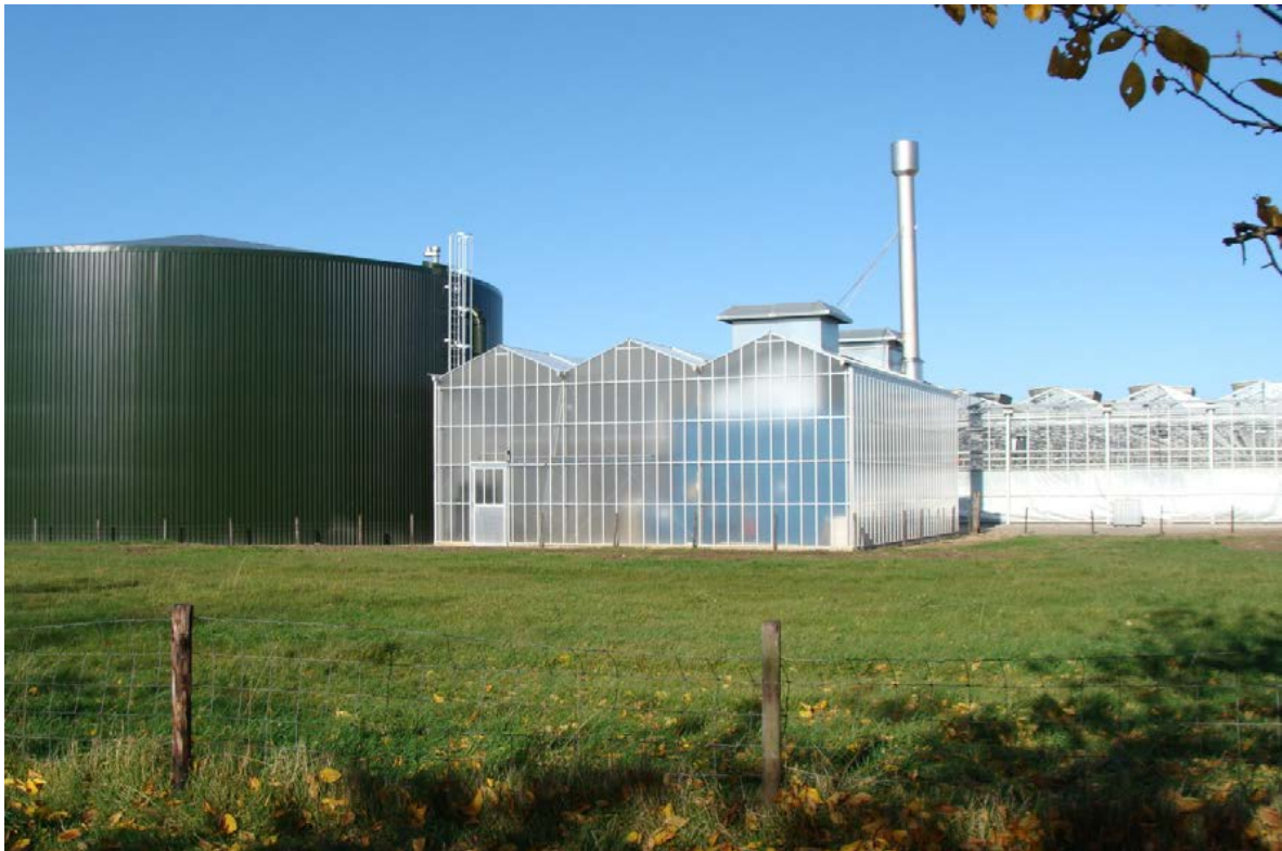
Wk-installatie met buffer
