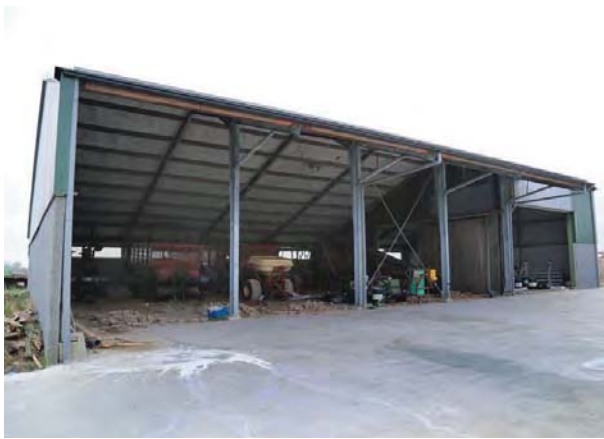
De bovenbouw van de jongveestal is verplaatst en wordt nu gebruikt als wagenberging annex stro-opslag. Het beton ervoor is niet gestort; een bouwklus die een tijdje was blijven liggen.
