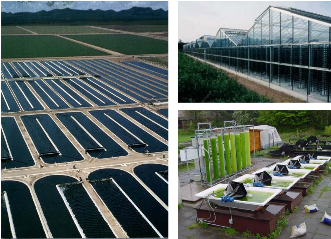
Figuur 2 Typen fotobioreactoren voor micro-algenteelt. Links: High Rate Algal Ponds, Earth Rise Farms, Californië, USA. Rechtsboven: Semi-gesloten fotobioreactor IGV, Potsdam, Duitsland. Rechtsonder: Pilot schaal cascade systeem ontwikkeld door ECN, UvA en IVAM [4].
