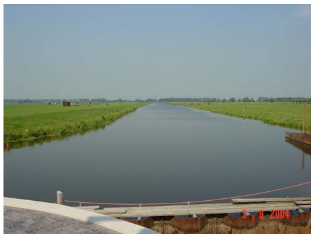
Figuur 2.2 Uitzicht vanaf het gemaal 'Krimpenerwaard'.
