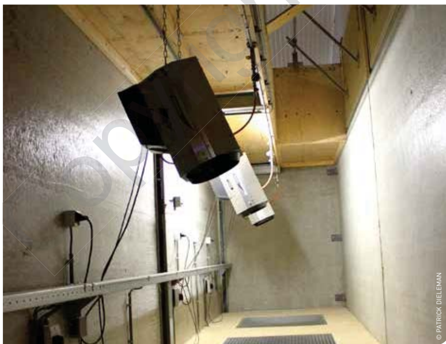
Wanneer de buitenlucht niet geschikt is voor droging, kan je met kachels de binnenlucht opwarmen om te drogen met interne ventilatie.
