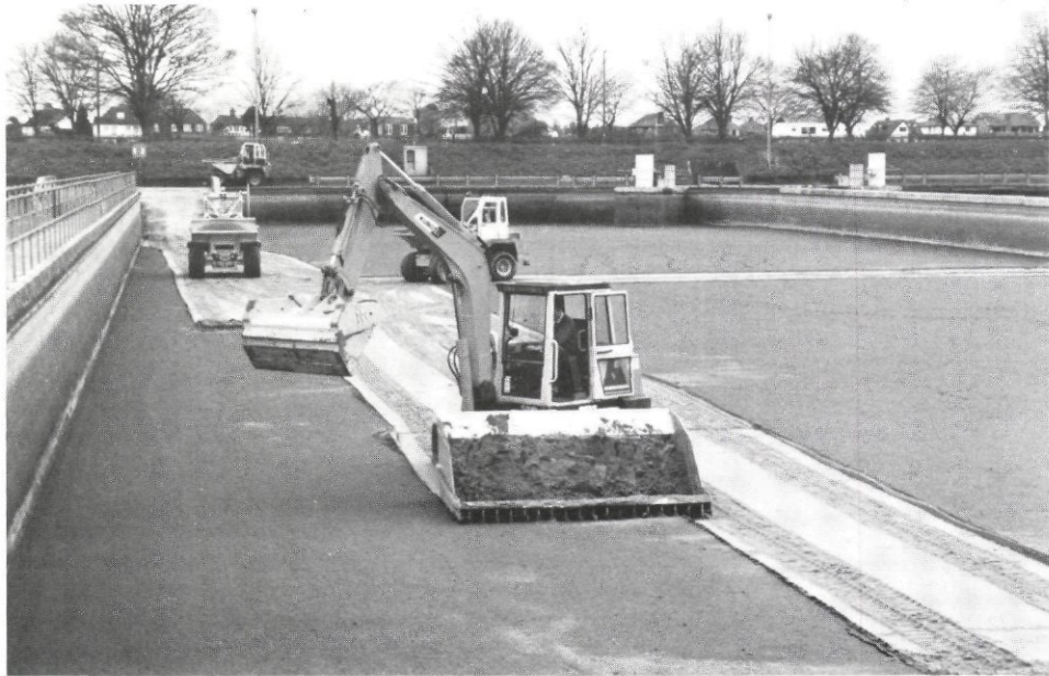
Afb. 1 - Eenmaal per 6-8 weken wordt de bovenlaag van de open langzame zandfilters in Londen verwijderd. [foto v.d. Hoek, GWA]
