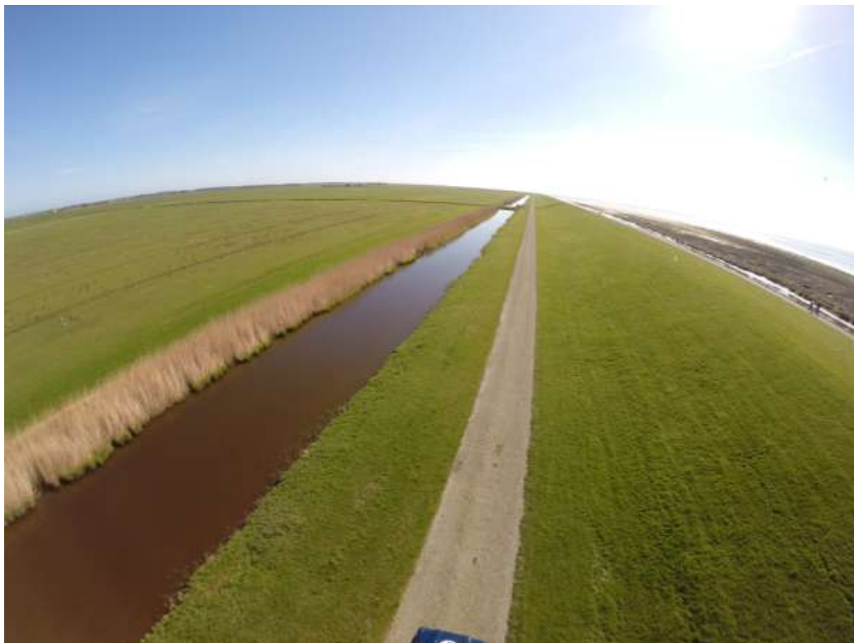
Afbeelding 1. Monitoring op Ameland, de Waddenzeedijk. Hier is een eerste versie van een simulatiemodel ontwikkeld om stroomsnelheden van kwelwater te koppelen aan temperatuursveranderingen in het dijklichaam, op basis van warmte-uitwisseling in de tijd
