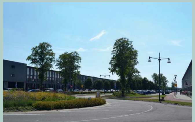
Ruim 45 lindes zijn van het talud bij de dijk verplaatst naar onder andere de nieuwbouwwijk Visveld. De Nationale Bomenbank deed de voorbereiding en BTL Bomendienst voerde de verplanting uit.
