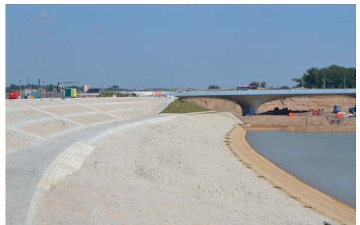
De kade is aangelegd als een zittribune. Er groeit al flink wat onkruid tussen de stenen. ‘We gebruiken geen chemie’, vertelt Van Ginkel. ‘We stomen of branden onkruid weg.’
