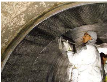
Figuur 11 Aanbrengen van een wrap in een betonnen leiding
