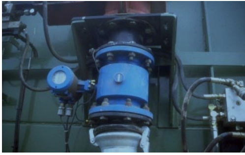
Figuur 5 Een magnetische doorstroommeter gemonteerd in een leiding.
