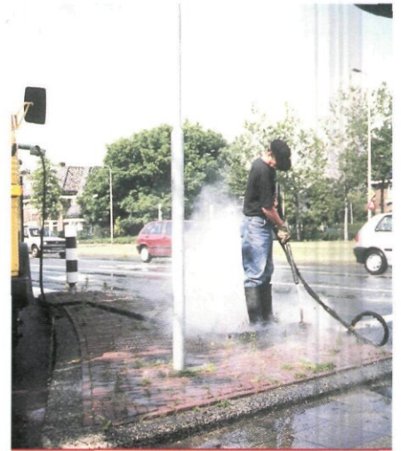
Duurzame bestrijding van onkruid door stomen (foto: Stichting Reinwater).
