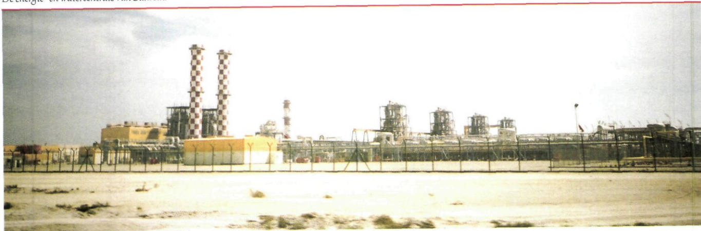
De energie- en watercentrale van Bahrein.
