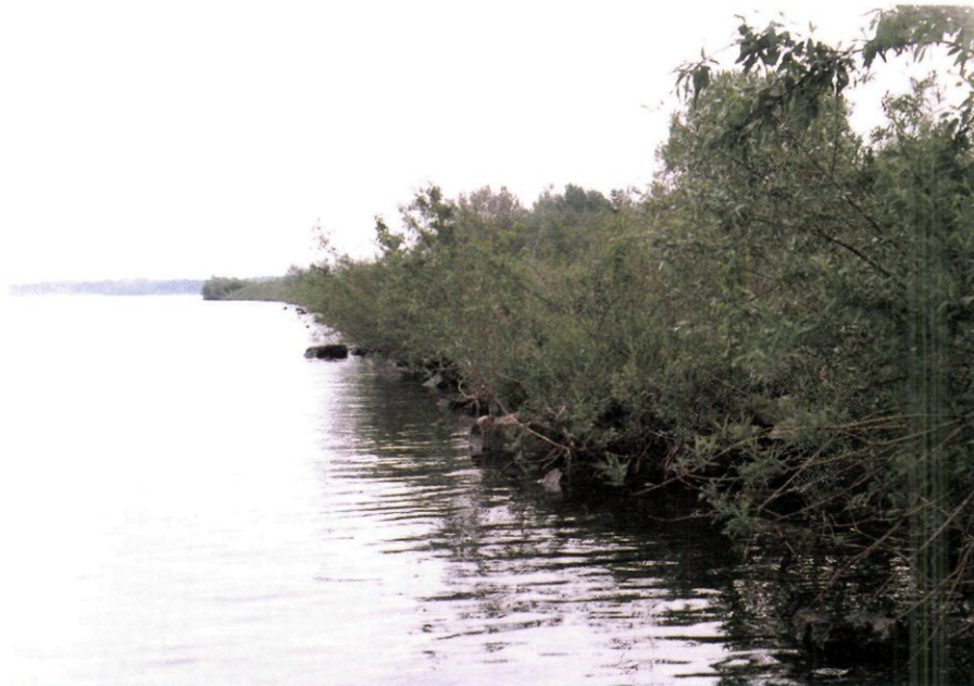
Biotechnische bescherming type B: rijpheidsfase (waterkant).
