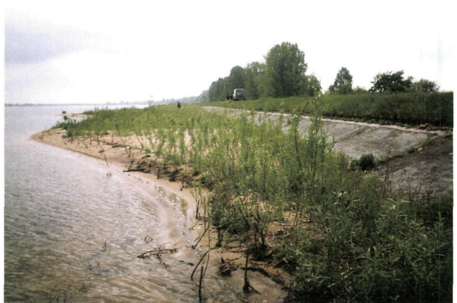
Biotechnische bescherming van de dijktaluds: groeifase.
