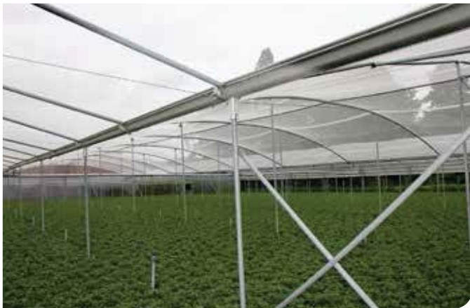
▲ Hagelnetten over een serreconstructie
