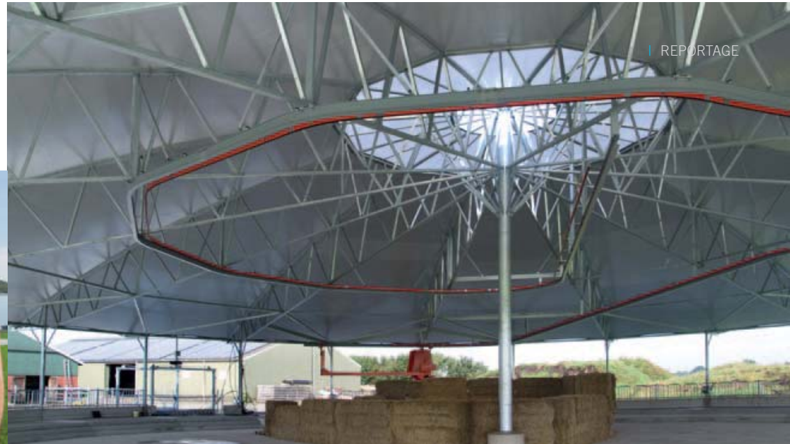
De stal kent een nokdiameter van 3,30 meter en een netto-opening van 6,45 meter. Aan de constructie hangt een rails voor de stroverdelers van 2,5 ton. Begin september herbergt de stal louter enkele balen. Hiertussen werd eind augustus een muzikaal optreden gehouden omdat de koepel een prachtige akoestiek levert.
