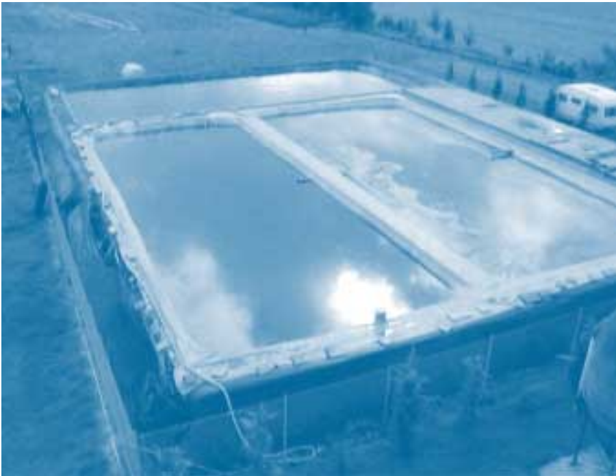
Figuur 3 Bezinkingsbassins van biologische mestbehandelingsinstallatie Biovink (Evink, Oosterwolde (Gld))
