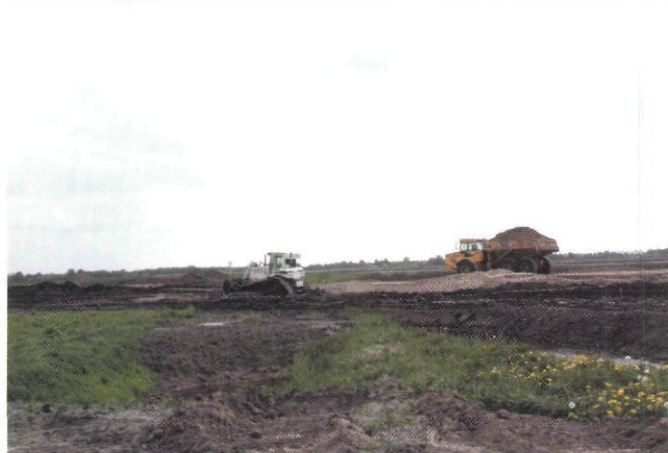
De eerste graafwerkzaamheden.
