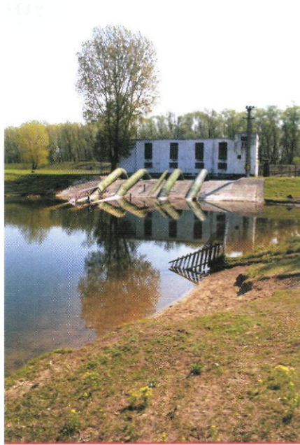
Pompstation voor irrigatiewater vanuit de rivier de Prut.
