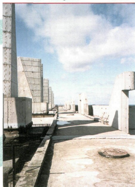
Eén van de zes uitwateringssluizen.
