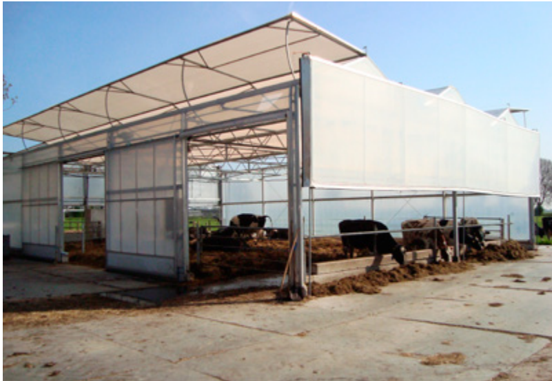
Een foliekas voor ca. 12 koeien met ventilatiemogelijkheden door het dak
