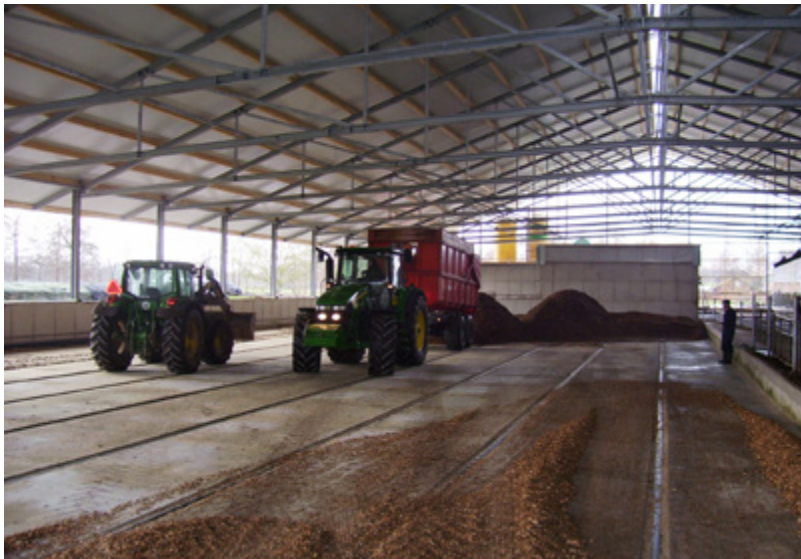
Aanleg stal in december 2010 met beluchtingsbuizen. Een halve meter houtsnippers wordt in de stal gebracht. Bodem wordt belucht via buizen in onderlaag.
