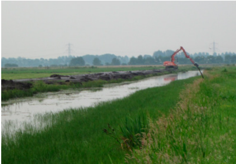
Bagger wordt uit de sloot gehaald
