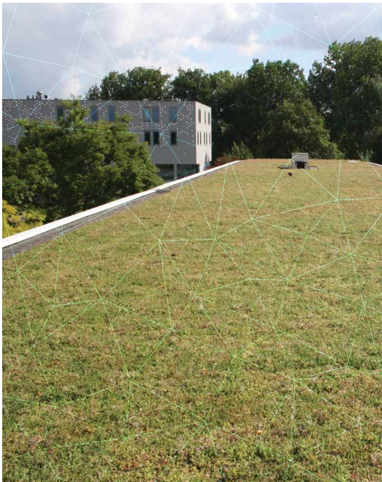
Een groen dak van Dakdokters (Foto: Dakdokters)
