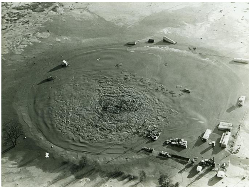
Figuur 5.9 Grote krater ontstaan bij de catastrofale blowout bij Sleen in december 1965 (bron: www.geschiedenis.thaantje.info )
