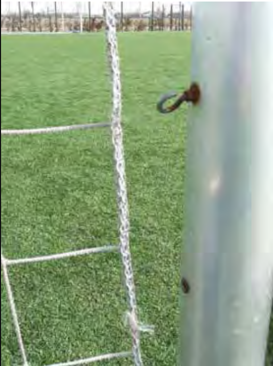
Een veelvoorkomend veiligheidsrisico bij voetbaldoelen: open nethaken.
