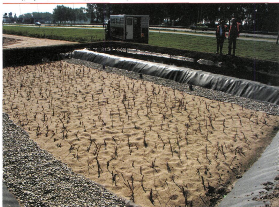
Het helofytenfilter (boven). De 'baggerweg' in aanleg (onder).
