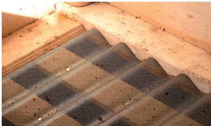
De geperforeerde bodemplaat is gegolfd, waardoor de brede latten waar de bodemplaat op rust de gaatjes niet afsluiten
