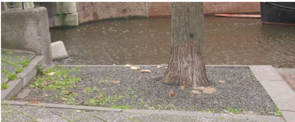
De Wittenkade in Amsterdam, boomspiegel met Epoxy. Sinds voorjaar 2006. Mulder: "Wij van beheer denken dat door het periodiek schoonspoelen van het rondje met behulp van hogedruk er minder kans op kruidengroei aanwezig is. (On)kruidgroei heeft een voedingsbodem nodig. Het aanwezige vuil tussen de poriën van epoxy geeft dan aanleiding hiervoor. Wel hebben wij het gevoel dat bij pas aangeplante jonge bomen het meer nadelige invloed heeft dan bij oudere bomen. Bij oudere bomen komt het probleem van het keuren van de boom op maaiveldniveau om de hoek kijken (dit is dan lastig).
