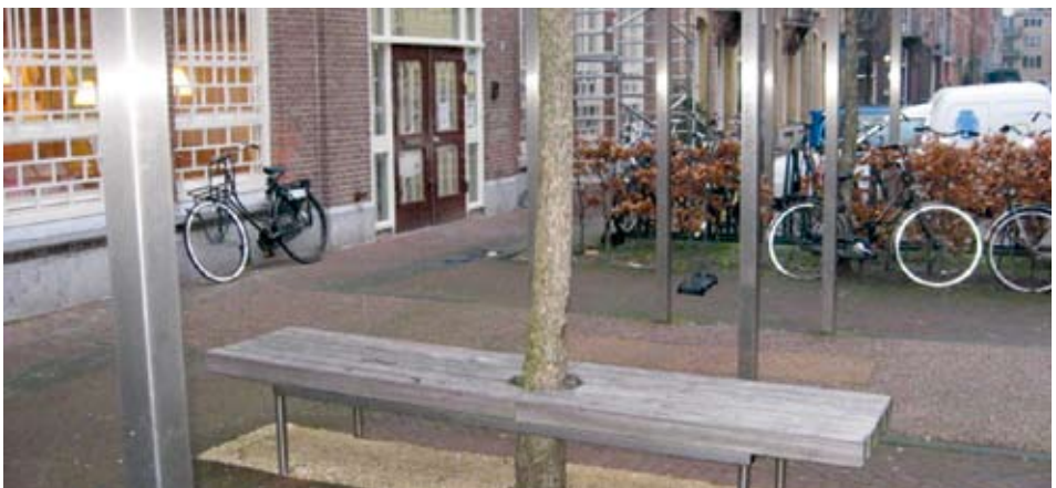
Cliffordstraat in Amsterdam, boomspiegel met siersplitdrainage (mengsel van Epoxy en gekleurd siersplit met een verharder). Sinds voorjaar 2002. Mulder: "Hier krijgt onkruid bijna geen kans. De Epoxy is namelijk vermengd met hars. Die hars zorgt voor stevigheid en die stevigheid is goed tegen onkruid."
