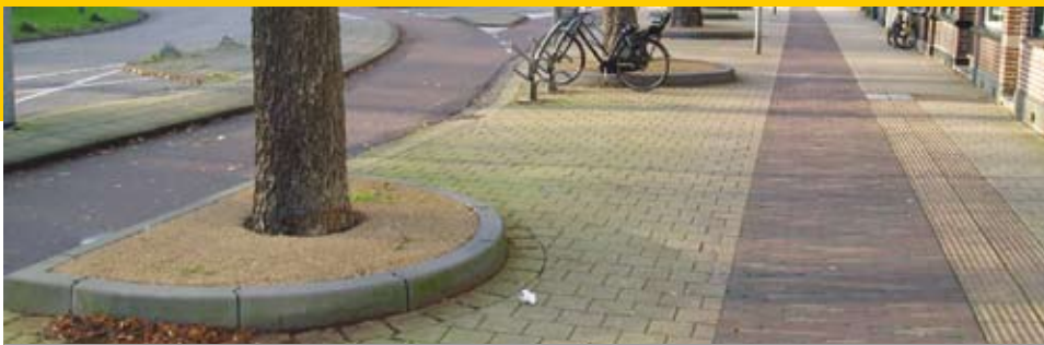
Alkmaar, boomspiegels met siersplitdrainage. Schatting: sinds 2003.
