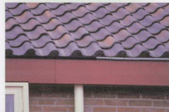
Aan het beplakken van de dakgoot is te zien of een bewoner heeft meegewerkt.
