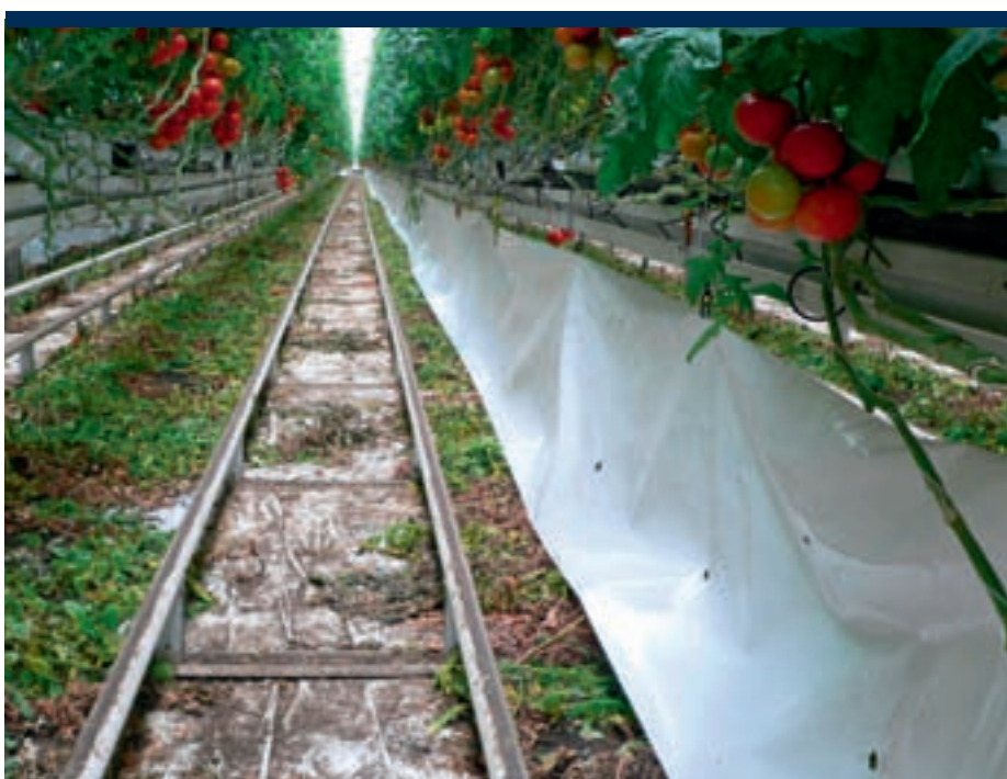
De tomatenteler verdeelt de buitenlucht via luchtslangen met een diameter van 45 cm met om de 80 cm gaten van 25 mm.
