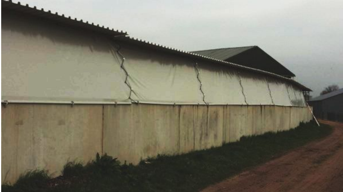
Figuur 2.7. Door de zeilen neer te laten kan de opening tussen dak en biobed afgesloten worden.
