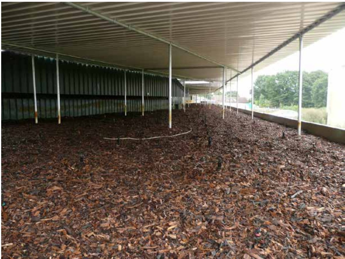
Figuur 2.6. Bovenaanzicht van het biobed. Tussen de houtsnippers bevinden zich sproeiërs voor reguliere bevochtiging van het bed.
