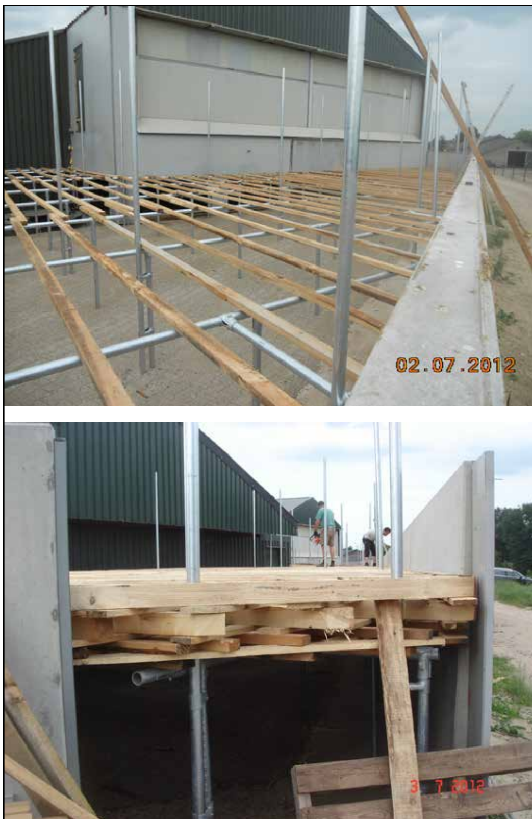
Figuur 2.2. Foto's van het in aanbouw zijnde biofilter. Op de bestrating staan de poten van een metalen constructie. Hierop worden de planken gestapeld. Onder de planken bevindt zich de drukkamer; bovenop de planken wordt later het biobedmateriaal (houtsnippers) aangebracht (foto's beschikbaar gesteld door Gemeente Horst aan de Maas).
