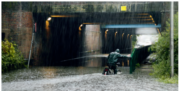
4.3 Schade: ondergelopen gebouw
