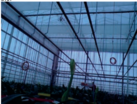
Figuur 17 Openlopen van het 1 e schermdoek (Schermopening met tijd) op 16 januari 2014. In figuur 18 de gemeten kas-, bloemknop- en scherm/kasdek temperatuur tijdens het openlopen van dit 1 e schermdoek.
