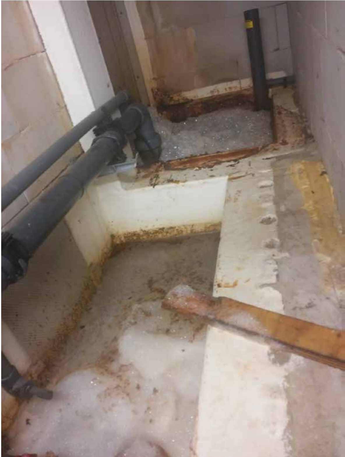
Figuur 10 Bij een aantal luchtwassers is aan de oppervlakte van het bassin schuim zichtbaar met daarop deels bruinig materiaal.
